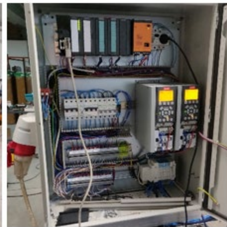
echipare și verificare componente panou de automatizare
