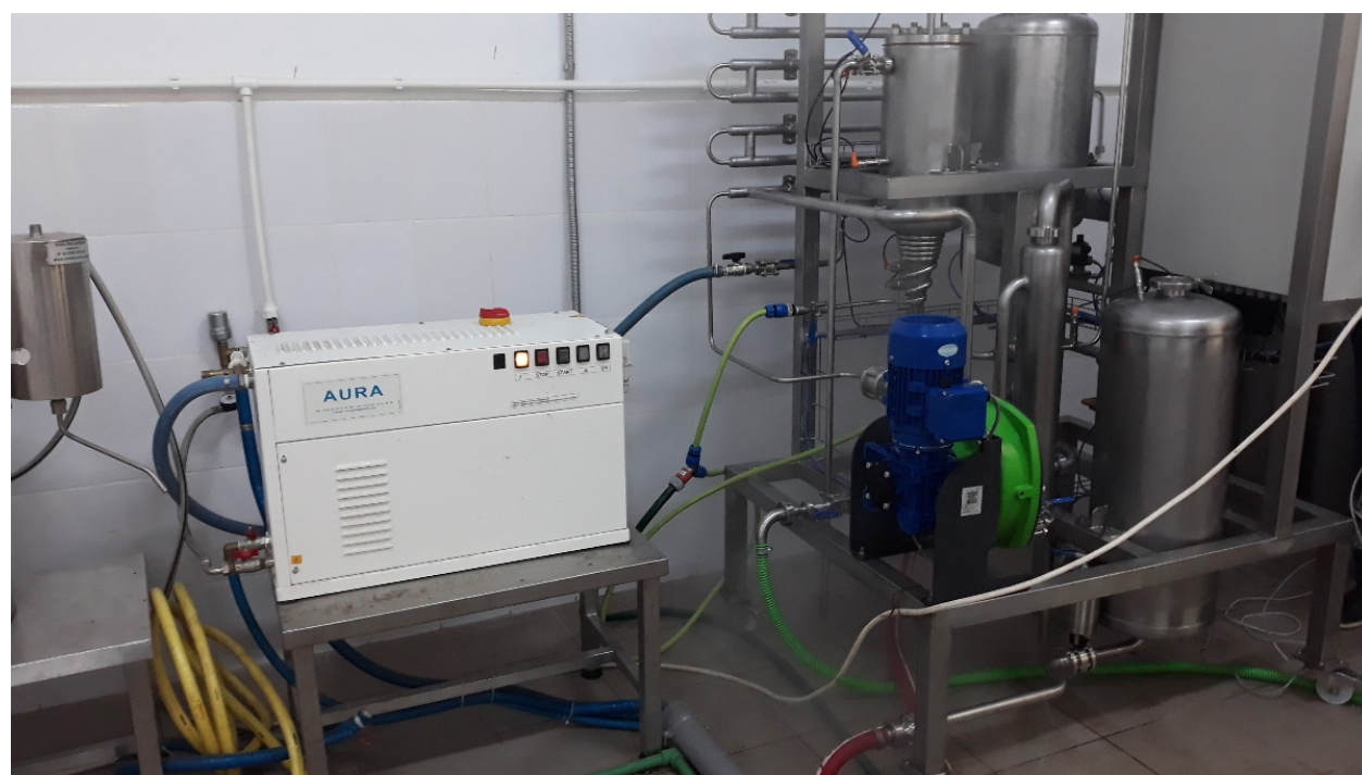
Cuplarea instalației la utilități, vas tampon și generatorul de abur
