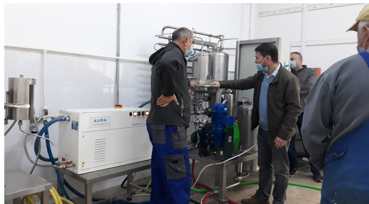
Aspecte privind verificarea instalației
