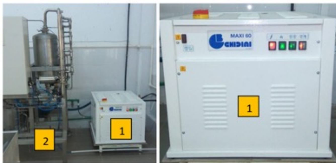
Figura 1 - Montaj generator de abur
