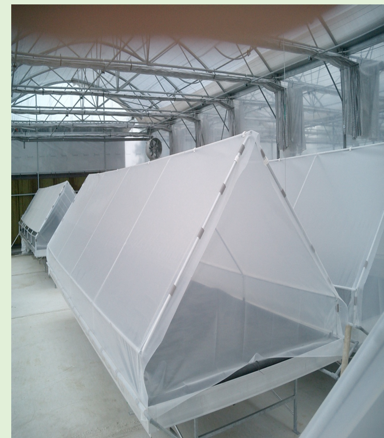
c) incinta de calusare (tunel)
